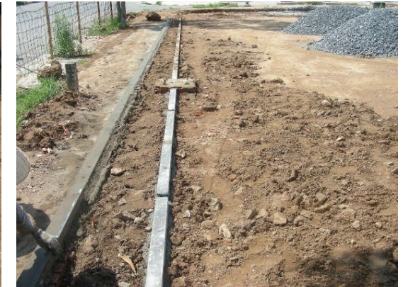
Bó vĩa bằng thanh BT đúc sẵn
