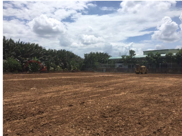
San ủi nền hạ bằng đất
