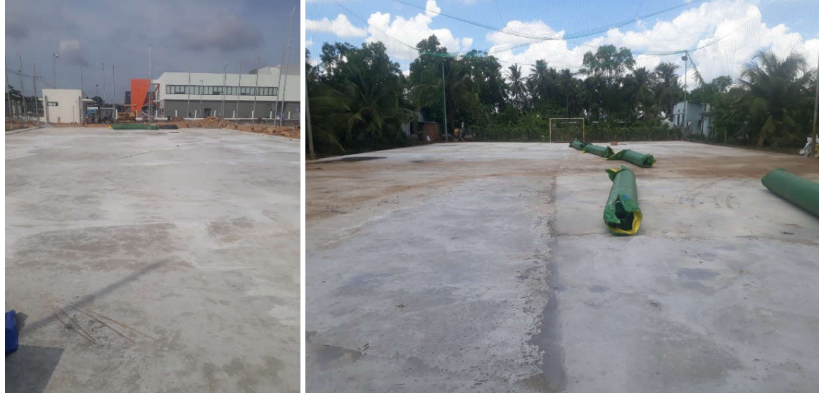
Nền bê tông sân bóng
