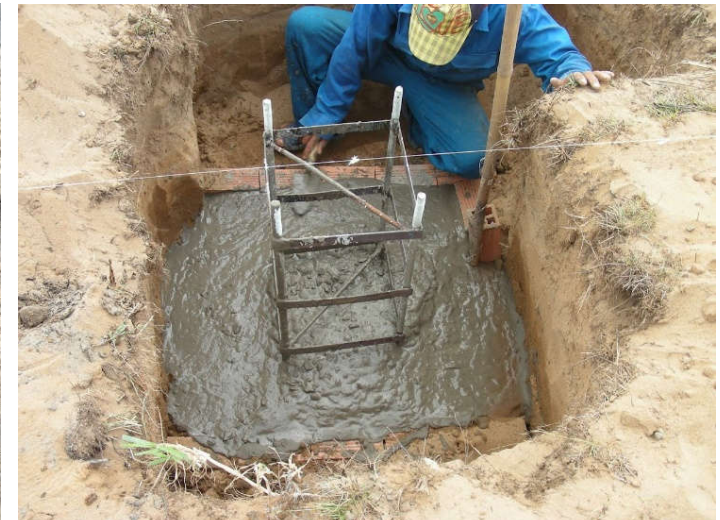
Đổ móng trụ đèn sau khi ủi nền hạ (2)
