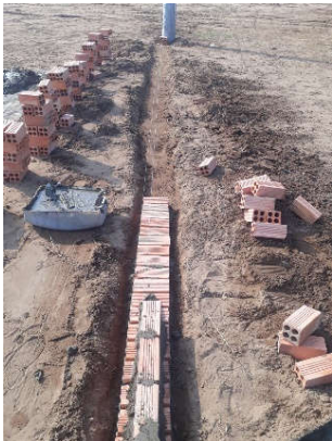
Bó vĩa bằng gạch ống
