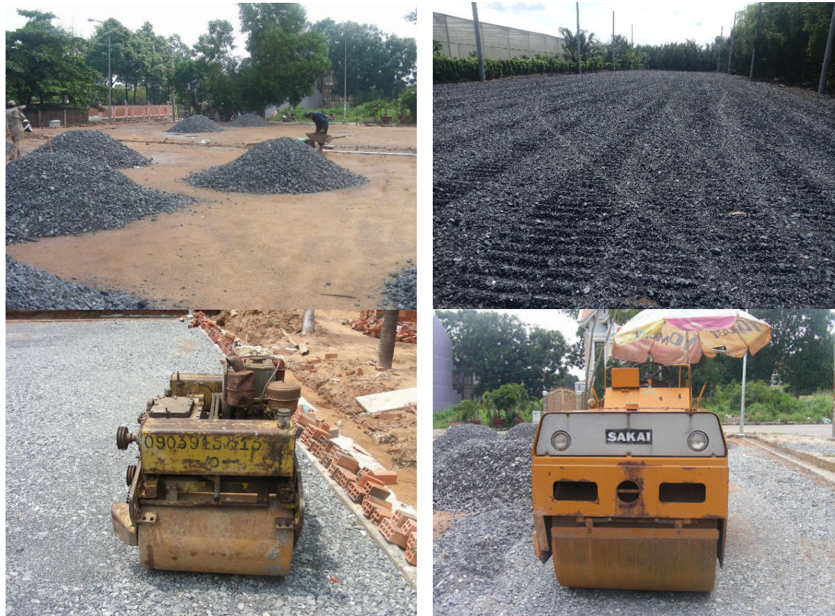
Rải đá 0x4 (cấp phối) và lu lèn
