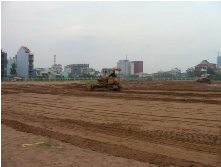
San nền hạ bằng cát san lấp
