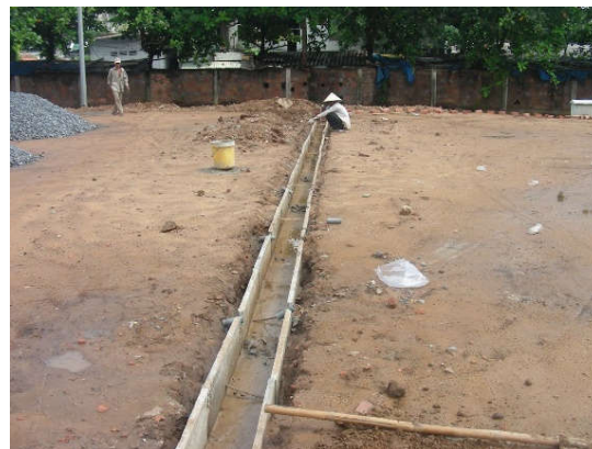
Bó vĩa bằng gạch ống
