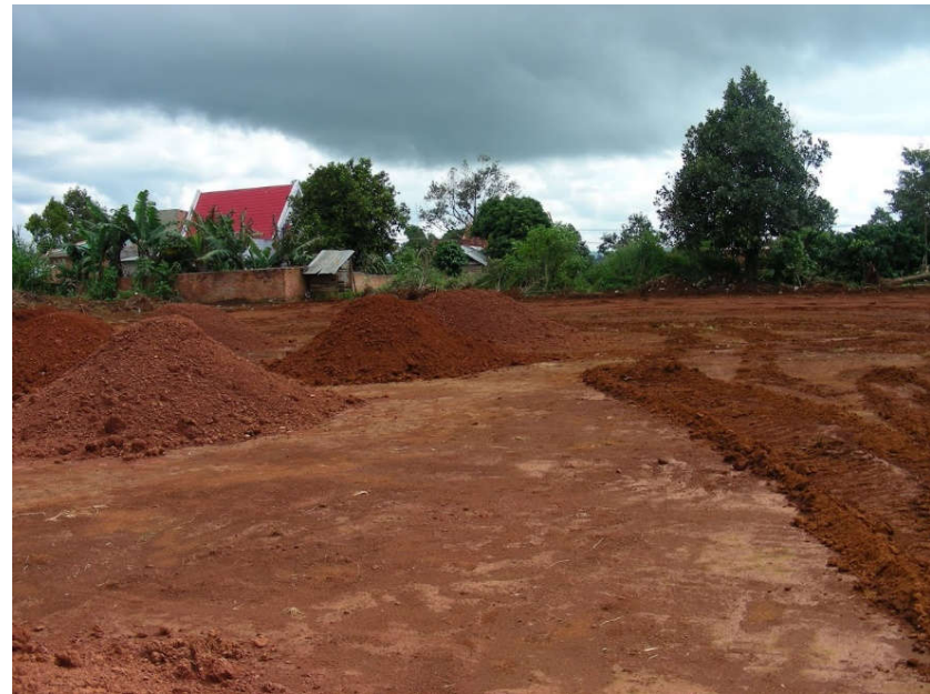
San lấp mặt bằng đất
